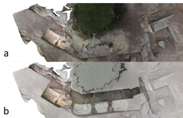
Figura 8: Vista cenital del búnker: a) modelo opaco; b) opacidad al 50% (permite ver la estructura interna del túnel).
